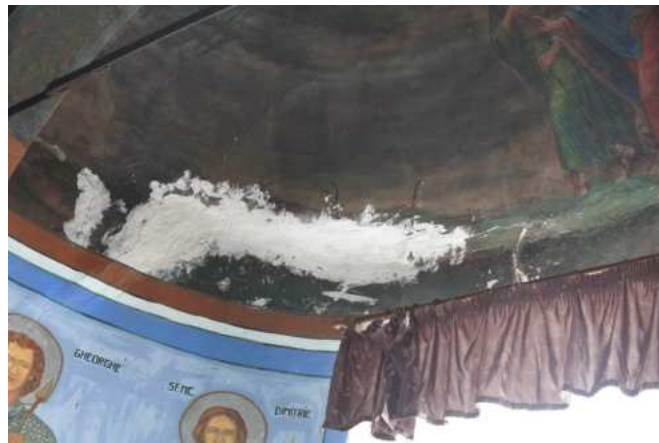
Reparații realizate în zona dintre masa de zidărie a pereților verticali și structura de lemn a bolților absidelor
