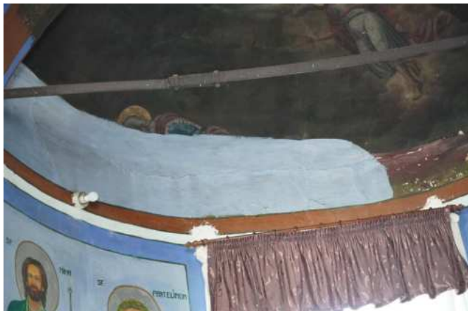
Reparații realizate în zona dintre masa de zidărie a pereților verticali și structura de lemn a bolților absidelor
