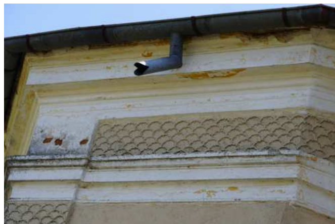
Intervenții la nivelul tencuielilor fațadelor
