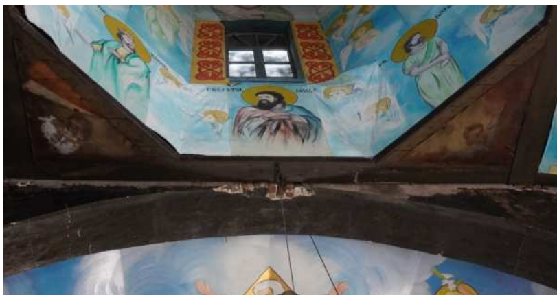
Desprinderi și deformări ale pânzei de la baza turlei
