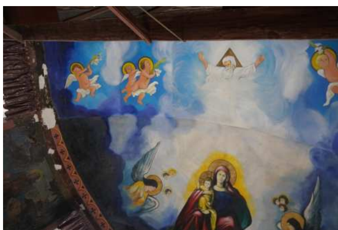
Conca altarului, intervenții realizate într-o manieră neprofesionistă
